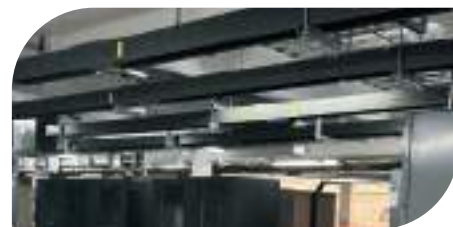
Instalación con electroducto
